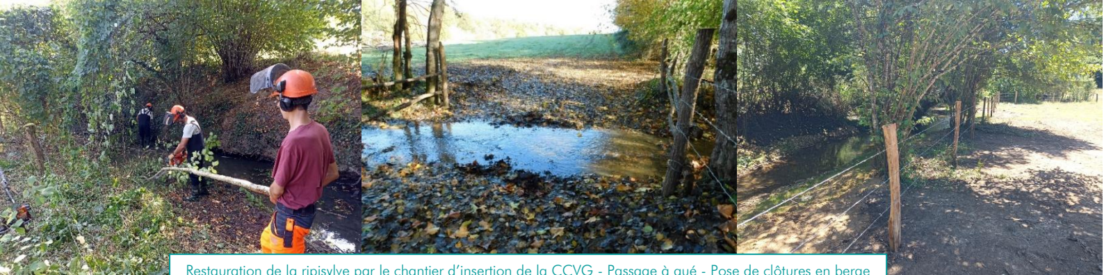
Restauration de la ripisylve par le chantier d'insertion de la CCVG - Passage à gué - Pose de clôtures en berge
